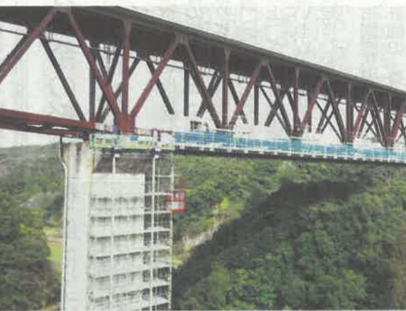
AWT工法を検証した西日本高速道路のトラス橋(開発者提供)
