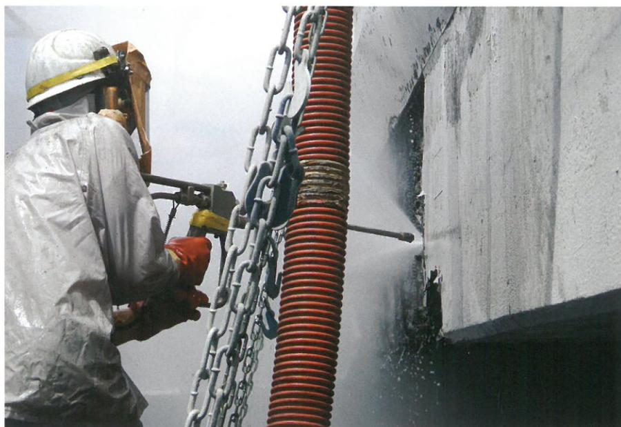
▲重防食塗装のかなめともいえる塗膜剥離・素地調整技術を世界中から取り入れ、修繕船、橋梁、トンネル工事などで現場に最適で安全な工法を提案。
