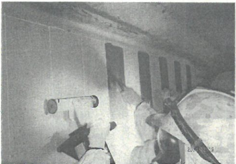
実橋梁で工法の作業状況
